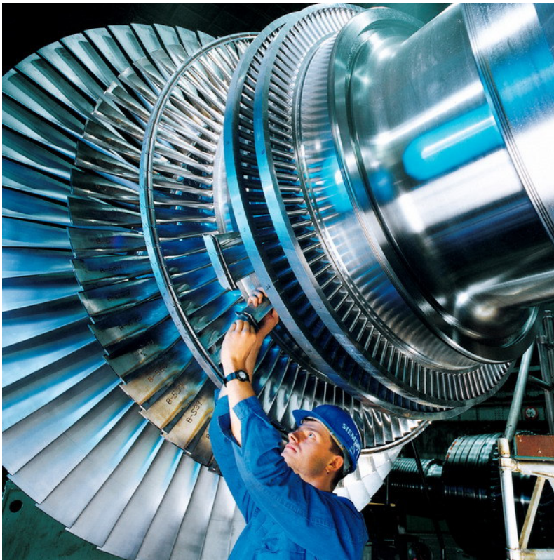
Schaufelmontage an einem Dampfturbinenrotor (Niederdruckbereich)
