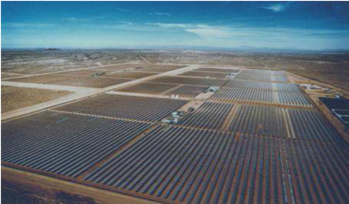
Abb. 1.1-1: Luftbild der solarthermischen Parabolrinnen-Kraftwerke bei Kramer Junction in der Mojave-Wüste in Kalifornien, USA
