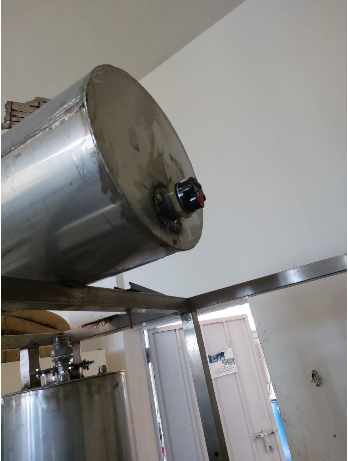
Tank 6 (Waste Tank) realisation:(07/04/2023)
