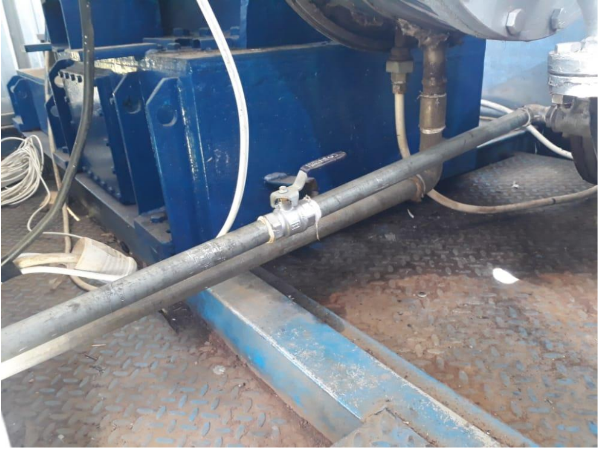
6.40 تركيب تنفيسة لمساعدة ال condensor
