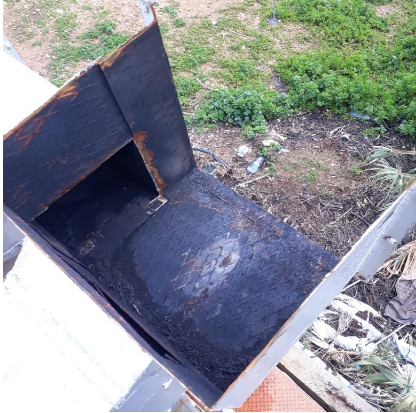
6.12 ترکیب ال exhaust fan
