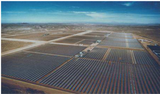
Abb. 1.1-1: Luftbild der solarthermischen Parabolrinnen-Kraftwerke bei Kramer Junction in der Mojave-Wüste in Kalifornien, USA
