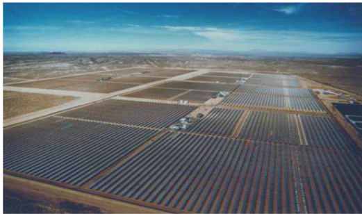
Abb. 1.1-1: Luftbild der solarthermischen Parabolrinnen-Kraftwerke bei Kramer Junction in der Mojave-Wüste in Kalifornien, USA
