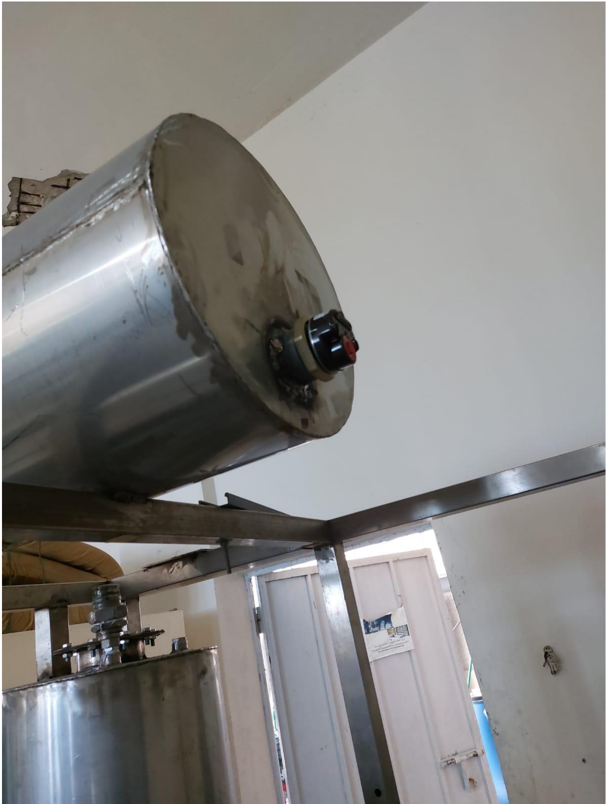
Tank 6 (Waste Tank) realisation:(07/04/2023)
