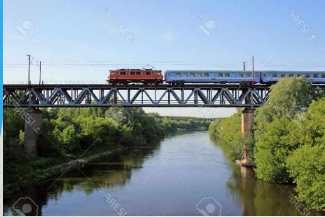
Steel bridge جسر حديدي
