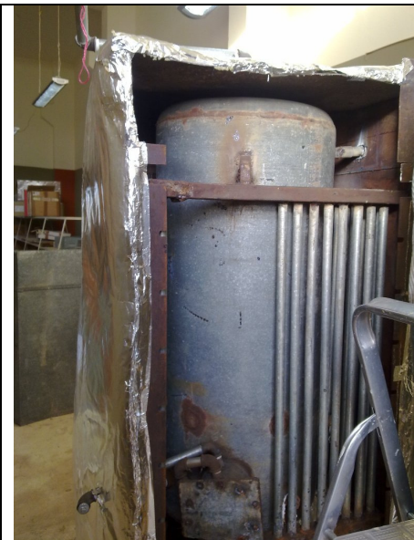
Thermalabdichtung Beklebung des Randes
