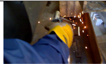
Bild oben rechts: geschweisste Hinterseite des Brennkammerzugs (Zug 1)
